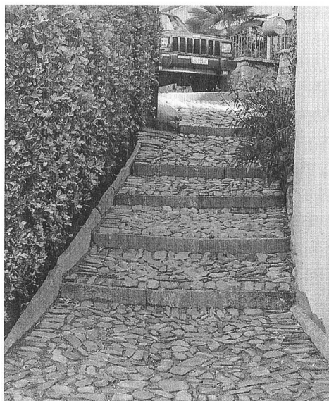
Abb. 107: Instandgestellte Schroppenpflasterung in Castaneda.
