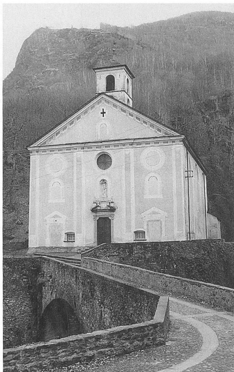
Abb. 106: Roveredo- Sant'Anna. Die restaurierte Eingangsfassade der Kirche Madonna del Ponte Chiuso.
