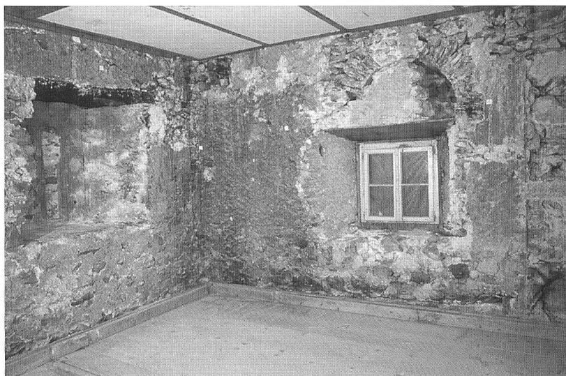
Abb. 49: Müstair, Kloster St. Johann. Plantaturm, 3. Obergeschoss: Südwestlichste Zelle ohne Täfer, Rundbogenfenster aus dem 10. Jahrhundert über dem aktuellen Westfenster, in der Südwand ein gotischer Fensterwagen mit Sturzbalken von 1317.
