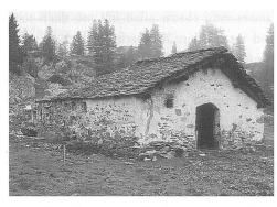
Abb. 152: Alp da Cavloc, Alte Sennerei. Ansicht von Südosten. Links oberhalb des Eingangstores ist das Rauchloch zu erkennen.
