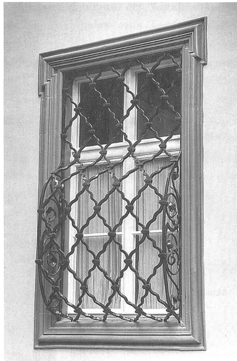
Abb. 127: Chur, Altes Gebäu. Korbgitter aus der Bauzeit 1727-29 im Erdgeschoss der Gartenfront.
