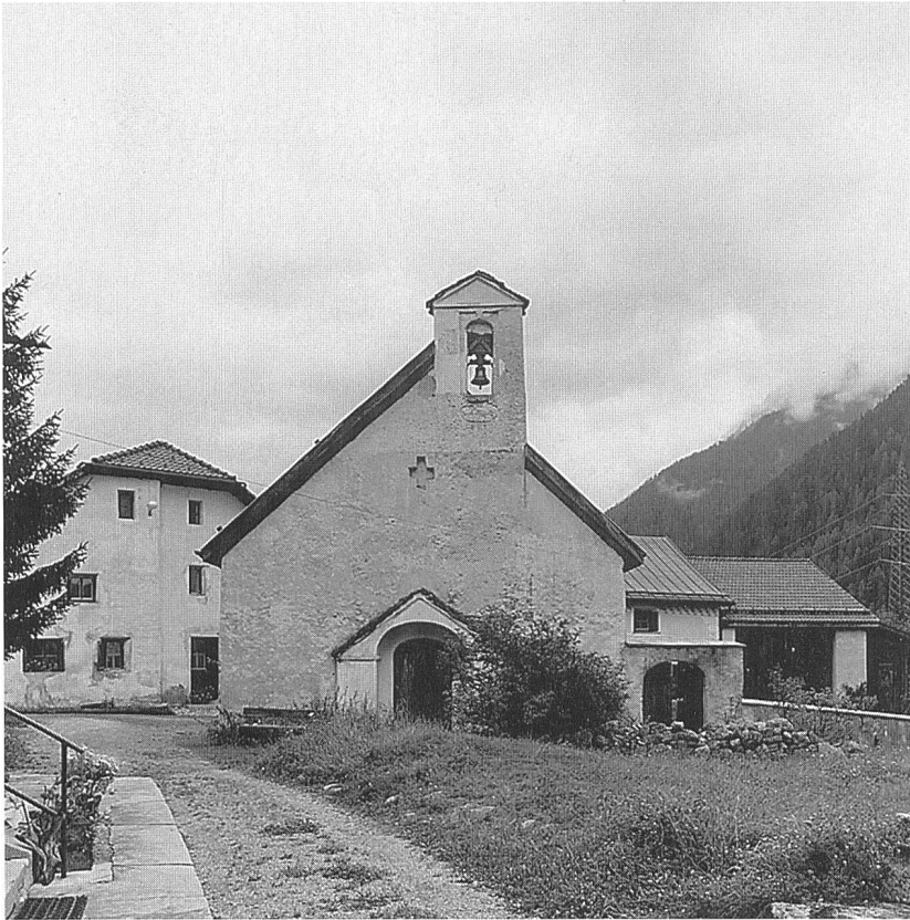
Abb. 118: Evangelische Filialkirche Garsun. Ansicht von Westen.
