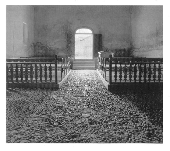
Abb. 120: Evangelische Filialkirche Giarsun. Bollensteinpflästerung mit sternförmigem Muster im Gehbereich des Schiffes. Ansicht von Osten.
