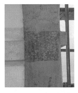
aber übereinander und auch die Farbgestaltung ist eine andere (Abb. 108). Der Befund ergab, dass die Rahmen der Füllungen und die sie flankierenden Ecklisenen ursprünglich grau gestrichen und danach mit weissen Farbspritzern aufgehellt worden waren. Dies ergibt eine Wirkung, die an dunklen Granit erinnert (Abb. 109).
