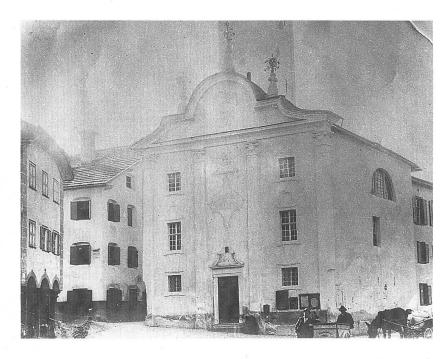
Abb. 107: Samedan, Dorfkirche Plaz. Diese Aufnahme von 1890 zeigt die klassizistische Fassung. Sie wurde bei der Restaurierung von 1965 für die Rekonstruktion der Detailformen der Eingangsfassade beigezogen.
