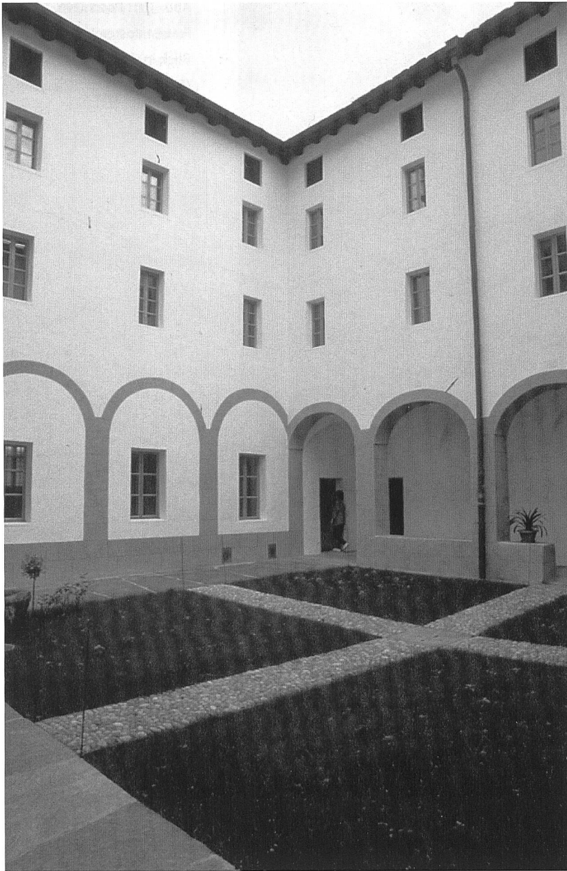
Abb. 103: Poschiavo, altes Frauenkloster. Der Kreuz- gang nach der Restaurie- rung. Südostecke.
