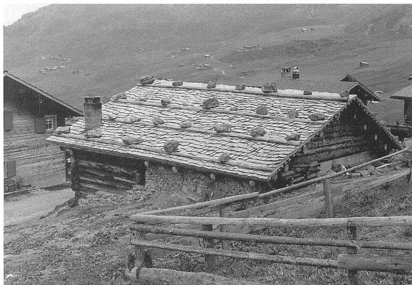
Abb. 85: Das Holzschindeldach erfreut sich zunehmender Beliebtheit. Im Bild das soeben fertiggestellte Schwarzdach auf der "alten Sennerei" in Strassberg, FONDEI. Die Schindeln sind in ursprünglicher Art mit Laten und Steinen beschwert.
