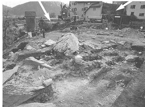
Abb. 20: Haldenstein, "Stein". Das Baugelände auf dem "Stein" von Nordosten, nach dem Abbruch der Gebäude 1998. Im Vordergrund die letzte Grabungsetappe des Friedhofs. Die Pfeile markieren Felsbrocken des Bergsturzes.
