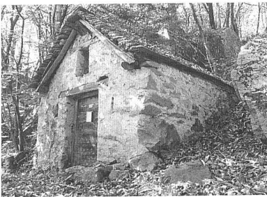
Einräumiger Kellerbau mit Dachraum.
