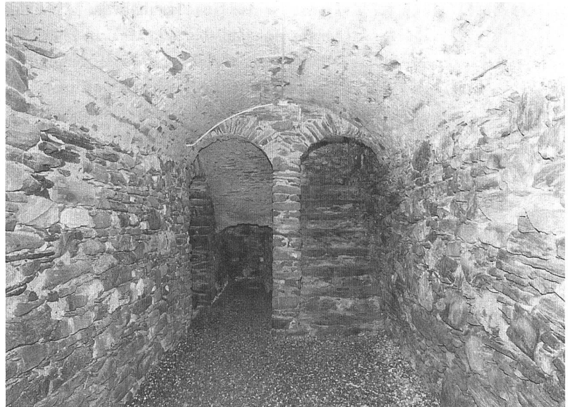
Abb. 97: Chur - Masans, Waisenhaus. Korridor im Untergeschoss mit stichbogigem Tonnengewölbe.
