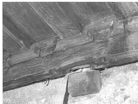
Abb. 76: Chur 1997/98, Kirchgasse 14 (Schniderzunft). Detail der spätgotischen Holzdecke nach der Freilegung, Zunfthaus, 1. OG.
