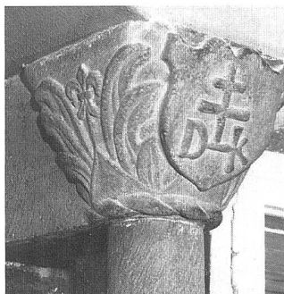
Abb. 73: Chur 1998/99, Reichsgasse 48. Fensterstütze aus Scalärstein.
