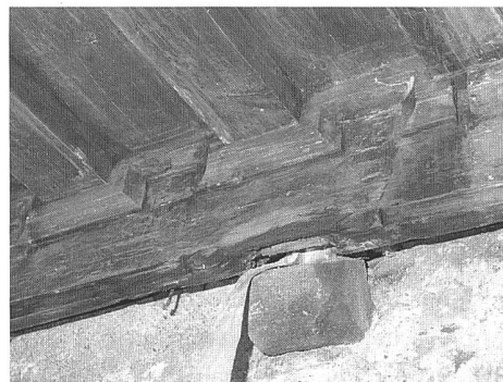
Abb. 76: Chur 1997/98, Kirchgasse 14 (Schniderzunft). Detail der spätgotischen Holzdecke nach der Freilegung, Zunftthaus, 1. OG.
