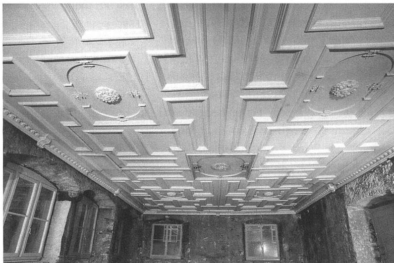
Abb. 79: Chur 1997/98, Kirchgasse 14 (Schniderzunft). Saal im 2. OG, um 1680 eingebaute Kassettendecke.
