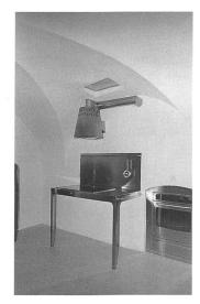
Abb. 23+24: Im 2. Obergeschoss (oberhalb der neuen Küche) wurde der Raumkomplex Bad, WC, Dusche, Hauswirtschaft, schrankartig in die Gangnische hineingestellt. Der alte Gangboden war zerstört. Der neue wurde aus Tannen- und Lärchenriemen abwechslungsweise schiffsdeckartig erstellt. Die alte Holzdecke wurde geflickt und mit Kalkfarbe lasierend getönt. Links im Bild jeweils die alte Treppe zum Estrich mit neuem Abschluss.
