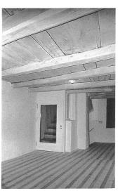
gemacht und geheizt werden. Der grosse Estrich bleibt als solcher erhalten, so dass die thermische Isolation horizontal auf dem Estrichboden erfolgen kann. Die Trennwand zum Heustall wird stallseits isoliert, um Eingriffe in die Substanz des Hauses zu vermeiden. Die Isolation der Aussenwände der oberen Schlafkammern sowie der Gangräume erfolgt raumseitig mit Dämmputz. Die Fenster der beheizten Räume werden restauriert und wo nötig aufgedoppelt.
