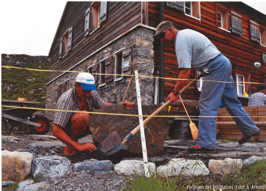
Verlegen des Vorplatzes (Foto: A. Arnold)
