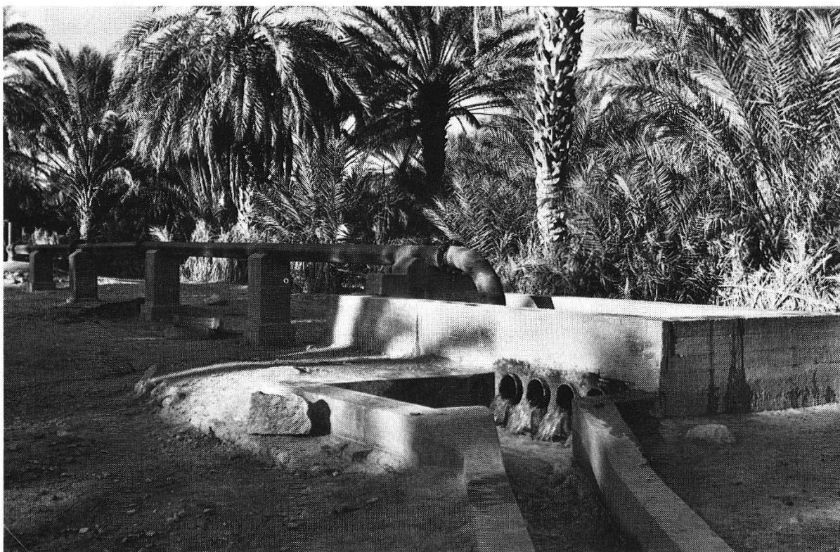
Fig. 3. Conduites d'irrigation en fonte ou en béton, fermées ou à ciel ouvert. Avantages agricoles: courant d'eau rapide; pertes d'eau par évaporation, faible, presque nulles par réabsorption dans le sol; peu d'entretien; irrigation plus efficace d'un périmètre plus étendu. Avantages sanitaires: assèchement à volonté.
