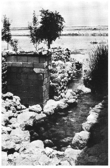
Fig. 2. Du «producteur» au «consommateur»! Une latrine est installée à quelques 3–4 m d'une source. Exemple typique de ce que peut être un «assainissement» bien intentionné, mais sans la moindre considération pour le problème sanitaire.
