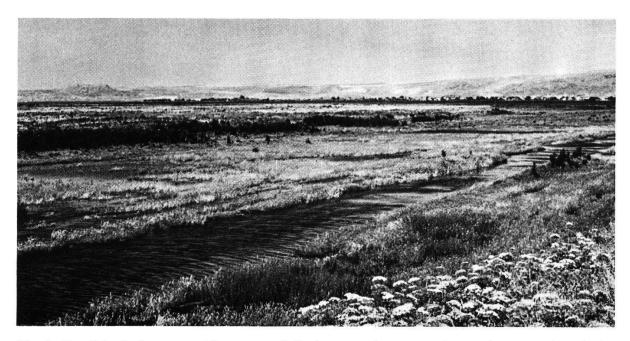
Fig. 1. Canal de drainage envahi par une végétation aquatique et semi-aquatique et qui ne draine plus le périmètre irrigué. Au deuxième plan, marécages secondaires et cultures abandonnées. Les eaux stagnantes ou peu courantes offrent d'excellent gîtes aux larves de moustiques et aux mollusques. En curant ce canal on rendrait service, autant à l'agriculture qu'à la santé publique.
