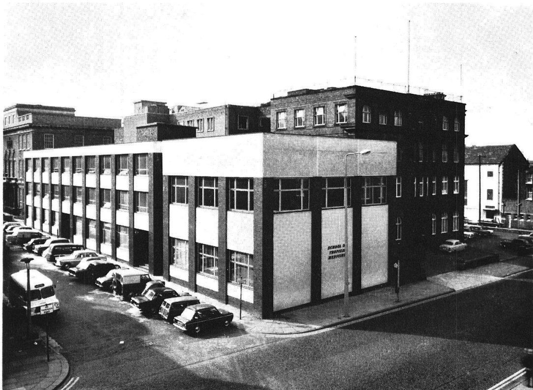
Fig. 2. Les nouveaux bâtiments de l'Ecole de Liverpool, inaugurés en 1966.
