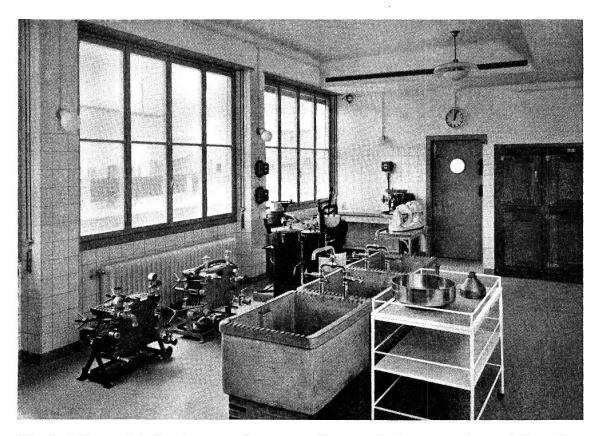
Fig. 6. Salle de fabrication avec les appareils pour le broyage, la centrifugation et la filtration du matériel virulent.
