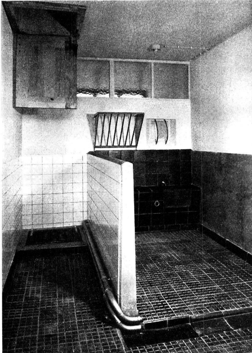
Fig. 7. Vue d'une partie de l'étable d'épreuve. Au plafond, trappe pour le foin et la paille. Sur le sol, couvercle de la fosse à fumier. Sur la cloison du fond, fenêtre pour l'observation.
