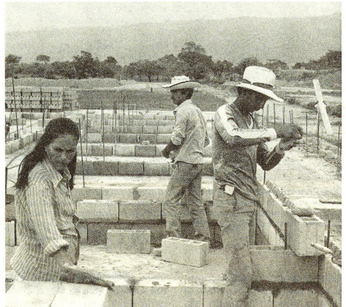
Ad Armero-Guayabal si costruisce secondo il principio dell'«autocostruzione»: i beneficiari partecipano ai lavori. Foto Kurt Bolliger
