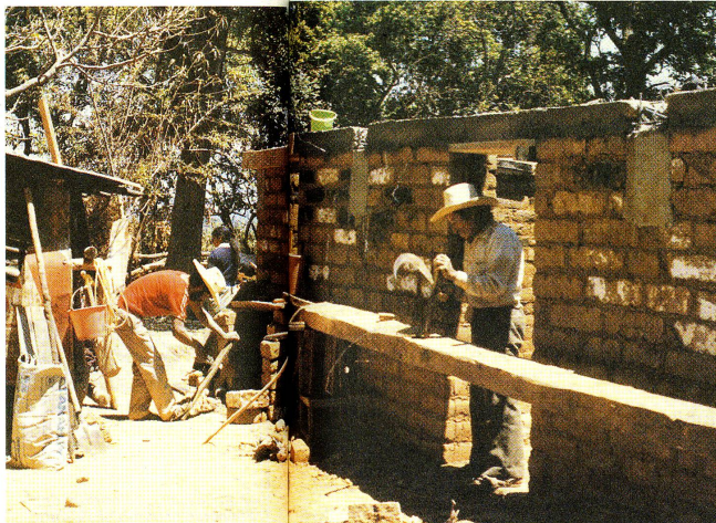
Nelle zone agricole si costruisce con gli «adobes» o mattoni crudi.
