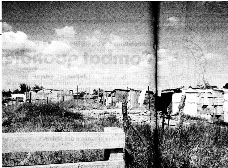
Au lendemain du tremblement de terre, les habitants des zones sinistrées vivent dans des abris provisoires, édifiés à l'emplacement de leur ancienne habitation. Cette situation précaire n'a guère évolué depuis le 10 octobre 1986.
