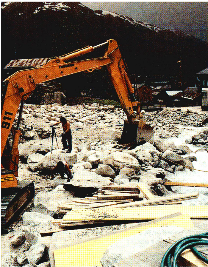
Le lit de la rivière est encore encombré de nombreux rochers qu'il faut enlever.
