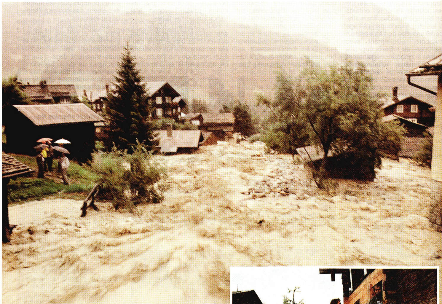
Münster après le 24 août 1987. Il a fallu attendre plusieurs jours avant de pouvoir évaluer les dégâts.
