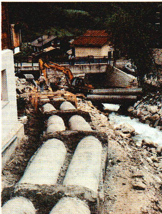
La rivière est provisoirement détournée par des canalisations.
