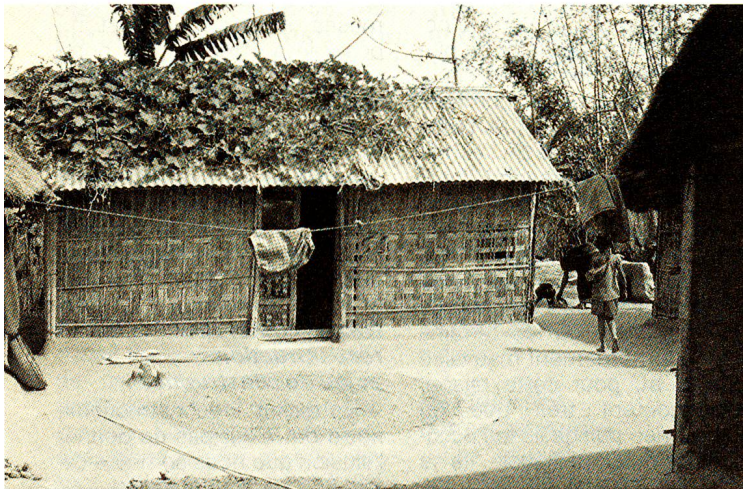
Les projets de reconstruction de la CRS respectent le mode de vie et les types d'architecture du pays. Comme cette maison en bambou, située dans un village du Bangladesh.
