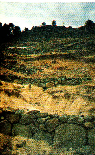
Dans le cadre du programme «Food for Work», des terrasses ont été édifiées. Elles permettent de limiter les effets de l'érosion.
