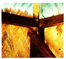
Détail de l'intérieur. Les matériaux locaux, ici les feuilles de bambou, sont systématiquement utilisées dans la construction
