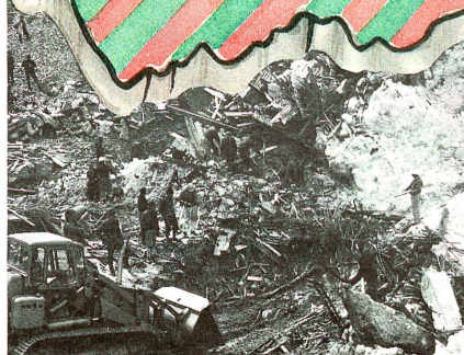
Tragédie de Martigny VS: un bloc de glace se détache et écrase le chantier de construction du barrage (1 er septembre 1965).
