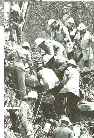
Destruction d'un immeuble locatif à Berne à la suite d'une fuite de gaz (13 avril 1986).
