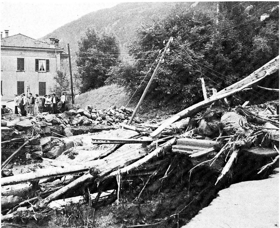
Foto a lato: *anche la val Blenio non è stata risparmiata dall'alluvione. Ad Acquarossa, il ponte sulla strada cantonale che porta al passo del Lucomagno è stato travolto dalle acque del riale Teja.*
