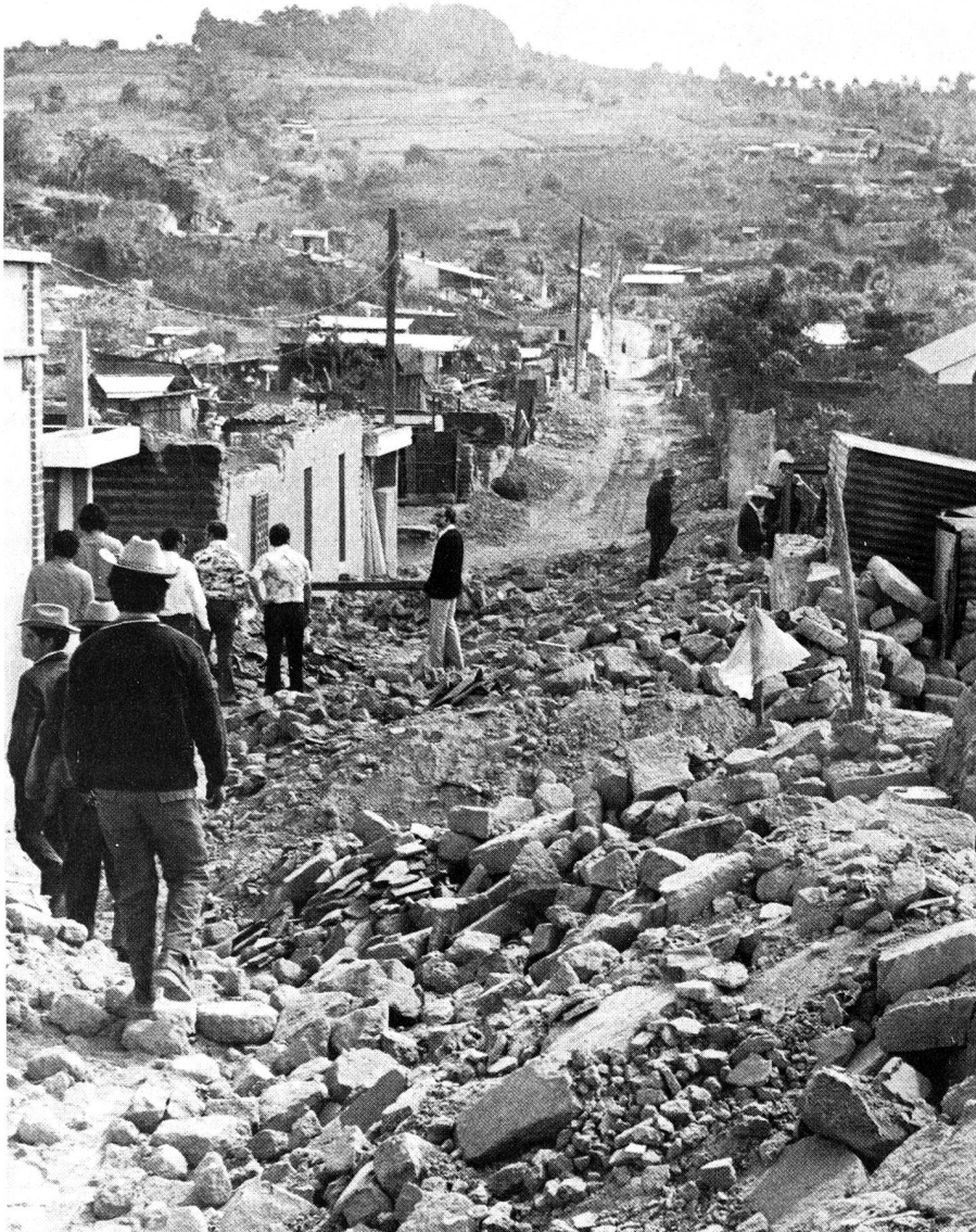
Santiago Sacatepequez, après le tremblement de terre de février 1976: de nombreux morts et blessés et environ 1200 maisons, détruites à près de 100 %.
