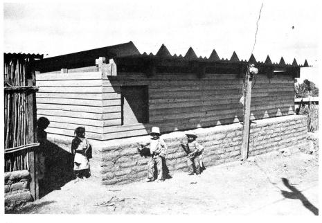
Maison achevée. Le toit à un pan est sensiblement plus stable que le toit sur pignons et donc plus résistant aux tremblements de terre. La plupart des maisons ont deux portes d'entrée et une porte intérieure, ainsi que deux fenêtres munies de volets, qui sont fabriquées sur place dans une menuiserie, dont l'installation faisait partie du projet. A l'intérieur, deux locaux sont séparés par une paroi de bois. Le plancher est fait de ciment et de chaux.
