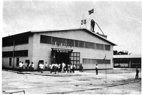
L'usine Duripanel de Viet-Tri, où se trouvent encore plusieurs autres fabriques de tuiles, de briques, de ciment, etc., offertes par des pays de l'Est, comprend une halle de fabrication de 2900 m² (notre photo), une halle de 1500 m² de surface utile pour la préparation du bois et le stockage (à droite), ainsi qu'un bâtiment annexe réservé à un laboratoire, à un bureau et à des locaux à usage social.
