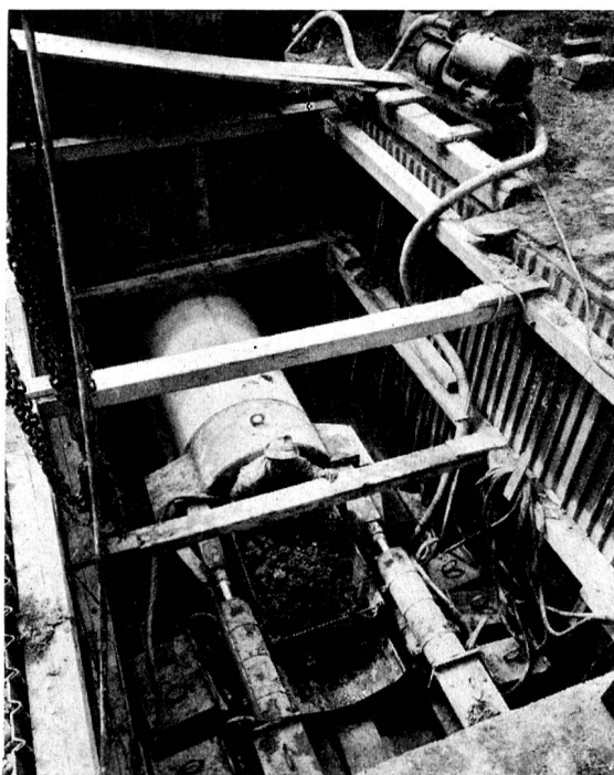
Pousse-tube en cours d'exécution
