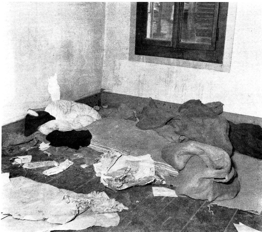
Un appartement encore d'une maison désaffectée, à Genève, où des sans-abris avaient cherché refuge et s'étaient « installés ». (Photo A. I. P., Genève)
