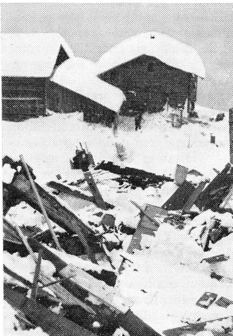
Au-dessus de Schiers deux avalanches ont causé de gros dégâts. Cinq personnes ensevelies sous la neige ont pu heureusement être retirées vivantes.
