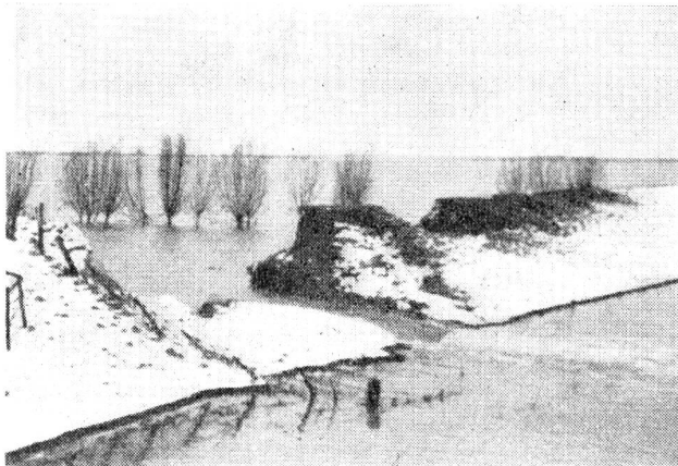
Par la digue défoncée, l'eau se précipite dans les campagnes hollandaises.
