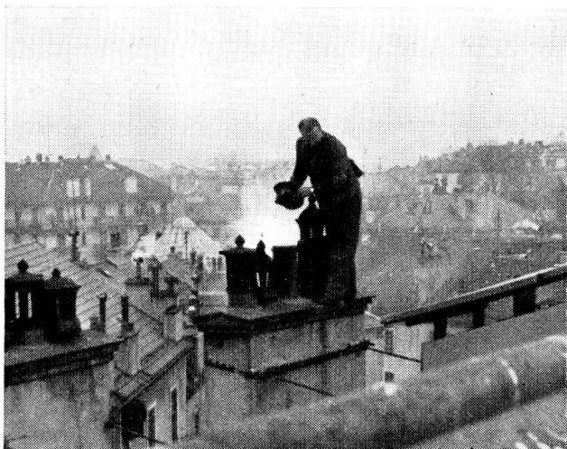
Mise sous pression d'une cheminée.
