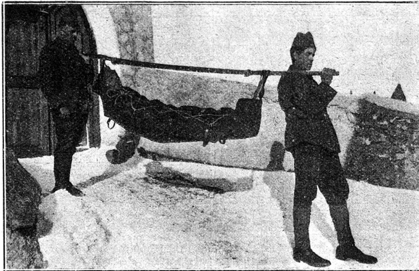
Délivrée de ses appuis fixes, la toile du brancard peut être soutenue par une hampe unique
