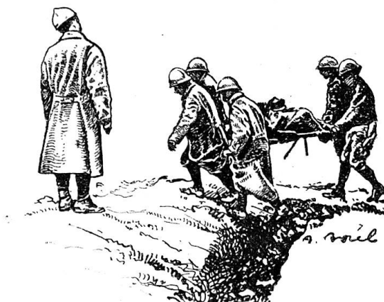
Hors des tranchées
