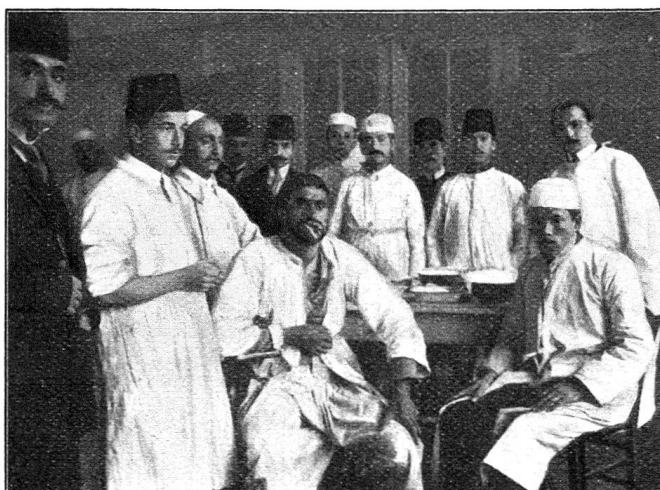
Vue de l'hôpital de la Colonie suisse de Péra (Constantinople)
