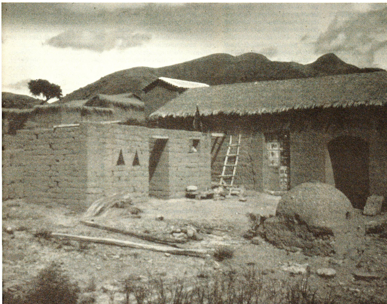
Einige Bauern ergreifen selbst die Initiative zu baulichen Verbesserungen. Zum Beispiel indem sie die Ritzen unter dem Strohdach, wo sich die Vinchucas mit Vorliebe einnisten, mit Verputz verschliessen. (Bilder: José A. Lambertín, Fernando Camargo)
