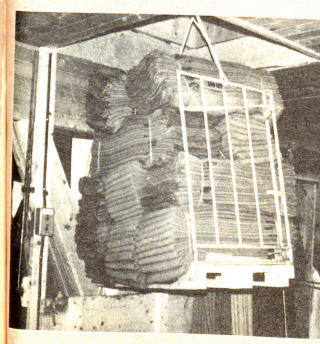
Mit einem improvisierten Lift wurde auf Estrichen gestapeltes Material auf abenteuerliche Weise heruntergeholt.
