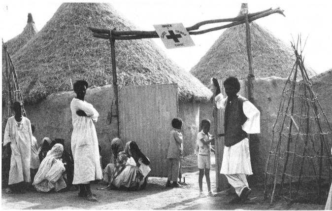
① Die SRK-Polyklinik in Wad Scheriffee. Sie entspricht in der Bauweise den Wohnhäusern der Flüchtlinge: Mauern aus Lehm, das Dach aus Stroh.
