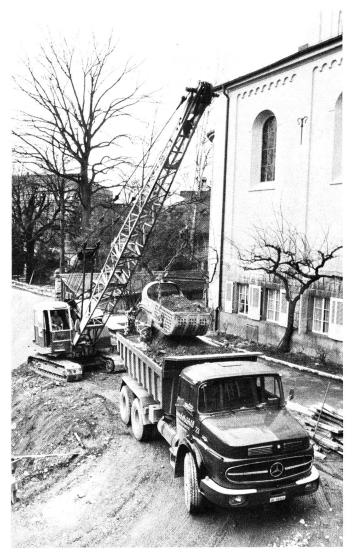
Die Bedienung dieses Baggers mit beweglichen Teilen verlangt viel Fingerspitzengefühl, Der Löffel fasst 1 m³, was hier einem Gewicht von etwa 3 t entsprach. Der Dreiachslaster kann 20–25 t laden. Im ganzen waren etwa 3800 m³ Aushub wegzuführen.
