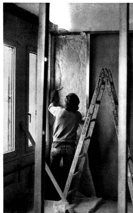
Die sogenannten «mobilen» Trennwände sind nicht beweglich, aber in Leichtbauweise hergestellt, so dass sie mit verhältnismässig geringem Aufwand versetzt werden könnten. Hier erkennt man deutlich, wie sehr die moderne Bauweise vom traditionellen Begriff des Hausbaus mit massivem Mauerwerk abweicht. Unten: Nochmals ein Blick auf den Bauplatz im Anfangsstadium.
