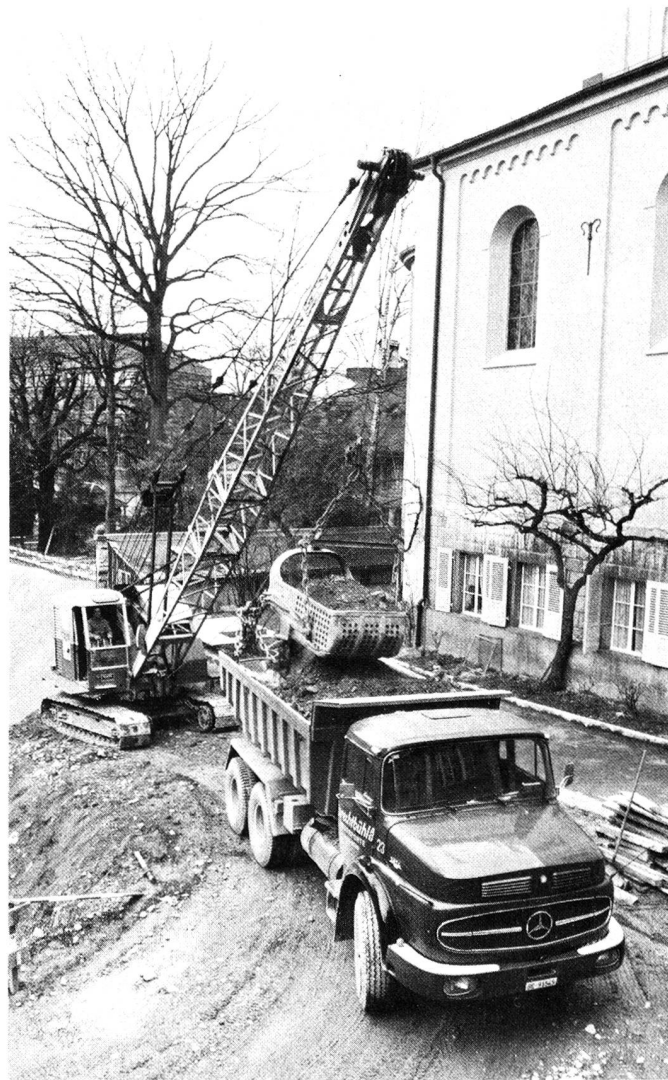
Die Bedienung dieses Baggers mit beweglichen Teilen verlangt viel Fingerspitzengefühl, Der Löffel fasst 1 m 3 , was hier einem Gewicht von etwa 3 t entspricht. Der Dreiaxslaster kann 20–25 t laden. Im ganzen waren etwa 3800 m 3 Aushub wegzuführen.
