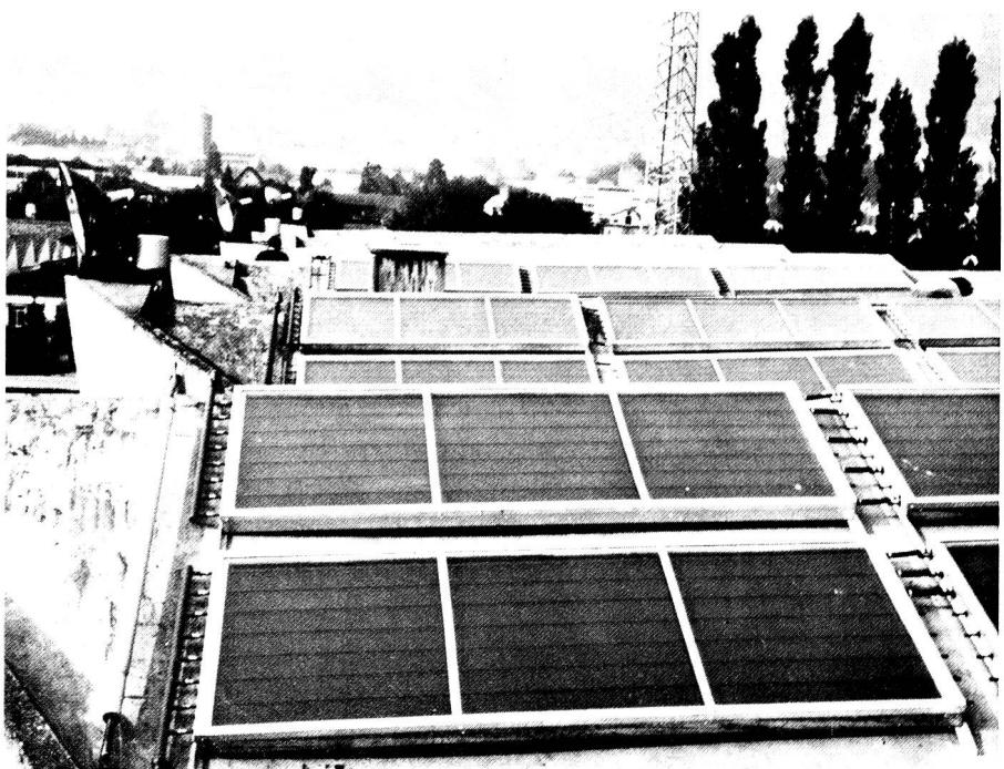
*Flachkollektoren auf dem Tribünendach eines Stadions in Grenchen, die das Warmwasser für die Duschanlage aufbereiten.*
