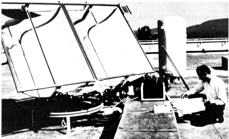
*Sonnenenergienutzung in der Berner Altstadt: Den unter dem Ziegeldach liegenden gefüllten Schläuchen wird die Wärme mittels einer Wärmepumpe entzogen.*
