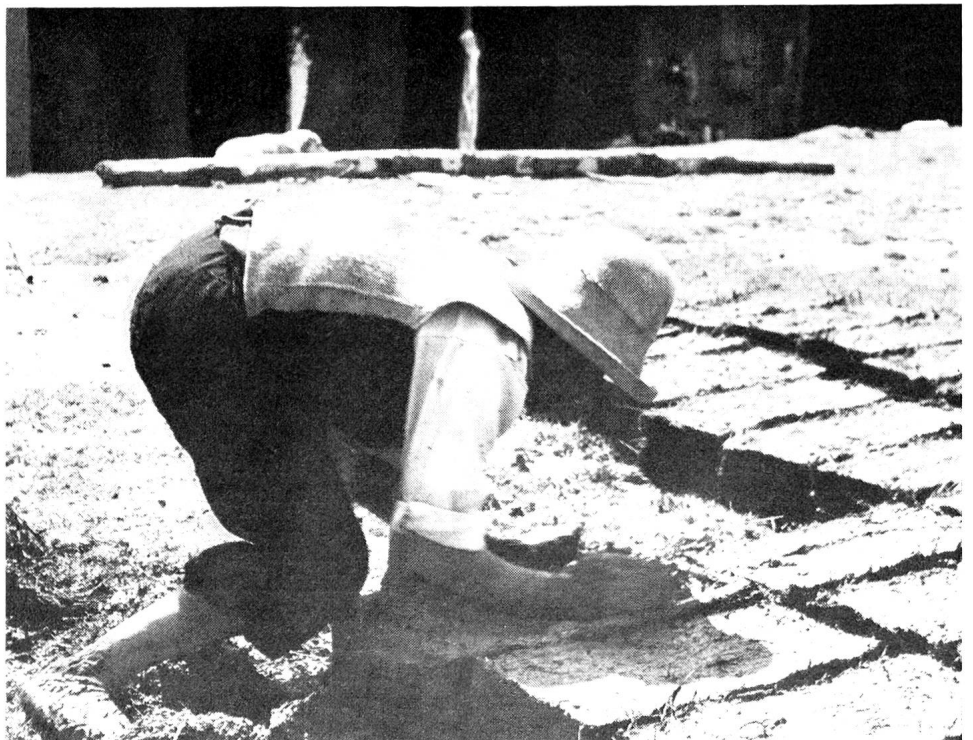
Für die Herstellung des Baumaterials wird feingesiebte Erde mit Wasser angerührt, mit kurzgehacktem Steppengras vermisch und in Formen gepresst. Diese Ziegel werden an der Luft getrocknet.
