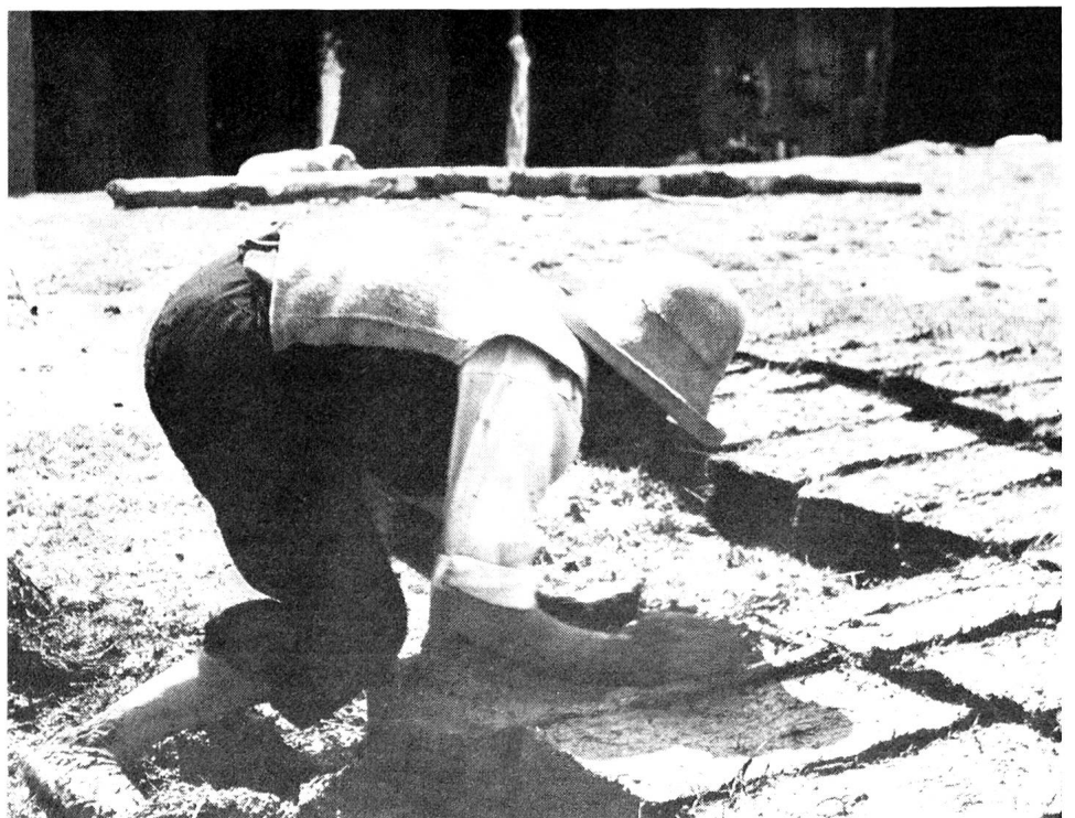
Für die Herstellung des Baumaterials wird feingesiebte Erde mit Wasser angerührt, mit kurzgehacktem Steppengras vermischt und in Formen gepresst. Diese Ziegel werden an der Luft getrocknet.
