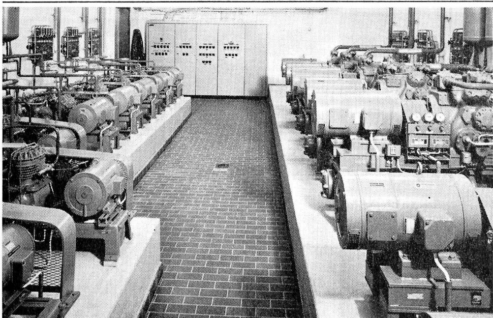
Das Bild zeigt den Kältemaschinenraum im Zentrallaboratorium, Blutspendedienst SRK, Bern. An diesen Kältemaschinen sind alle Kühl-, Tiefkühl- und Arbeitsräume im Temperaturbereich von +10 bis -60 °C und Geräte wie z.B. Fraktionierkessel und Zentrifugen angeschlossen.
