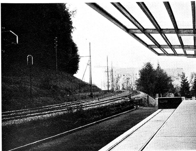
Die neue Bahnrampe erlaubt einen Warenumschlag in fast beliebigen Mengen. (Aufnahme: ehh.)
