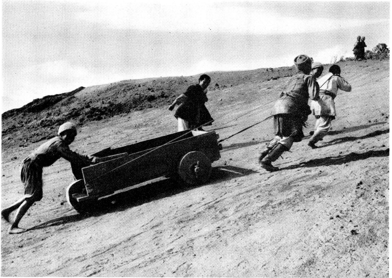
Oberes Bild: Solche selbstgebauten Karren dienen in Chialsa, Solu, für den Wegtransport des Aushubs beim Ausbau der Fluggpiste. Es bedarf der Zugkraft von fünf bis sechs Tibetern, um den Karren bergaufwärts zu ziehen. Unteres Bild: In einer windgeschützten Ecke arbeiten im Handwerkszentrum des Solu tibetische Spinnerinnen und Weberinnen. Fotos: Dr. Kurt Egloff
