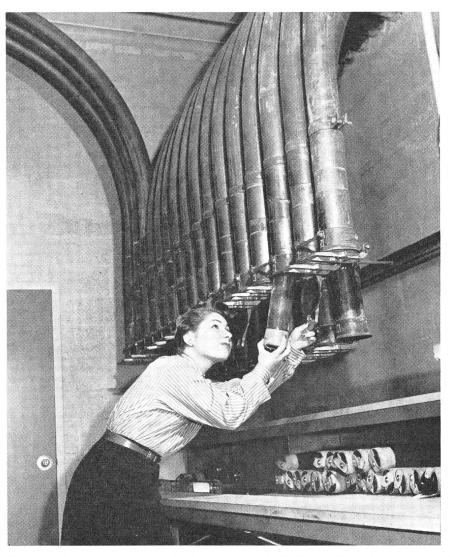
Das jüdische Spital auf Long Island ist mit einer kompletten Rohrpost ausgerüstet. Das Bild zeigt die Zentrale. Sämtliche Meldungen, Arzneibestellungen usw. gelangen in dieses Bureau und werden, je nach ihrem Bestimmungsort, in die betreffende weiterführende Röhre gelegt.
