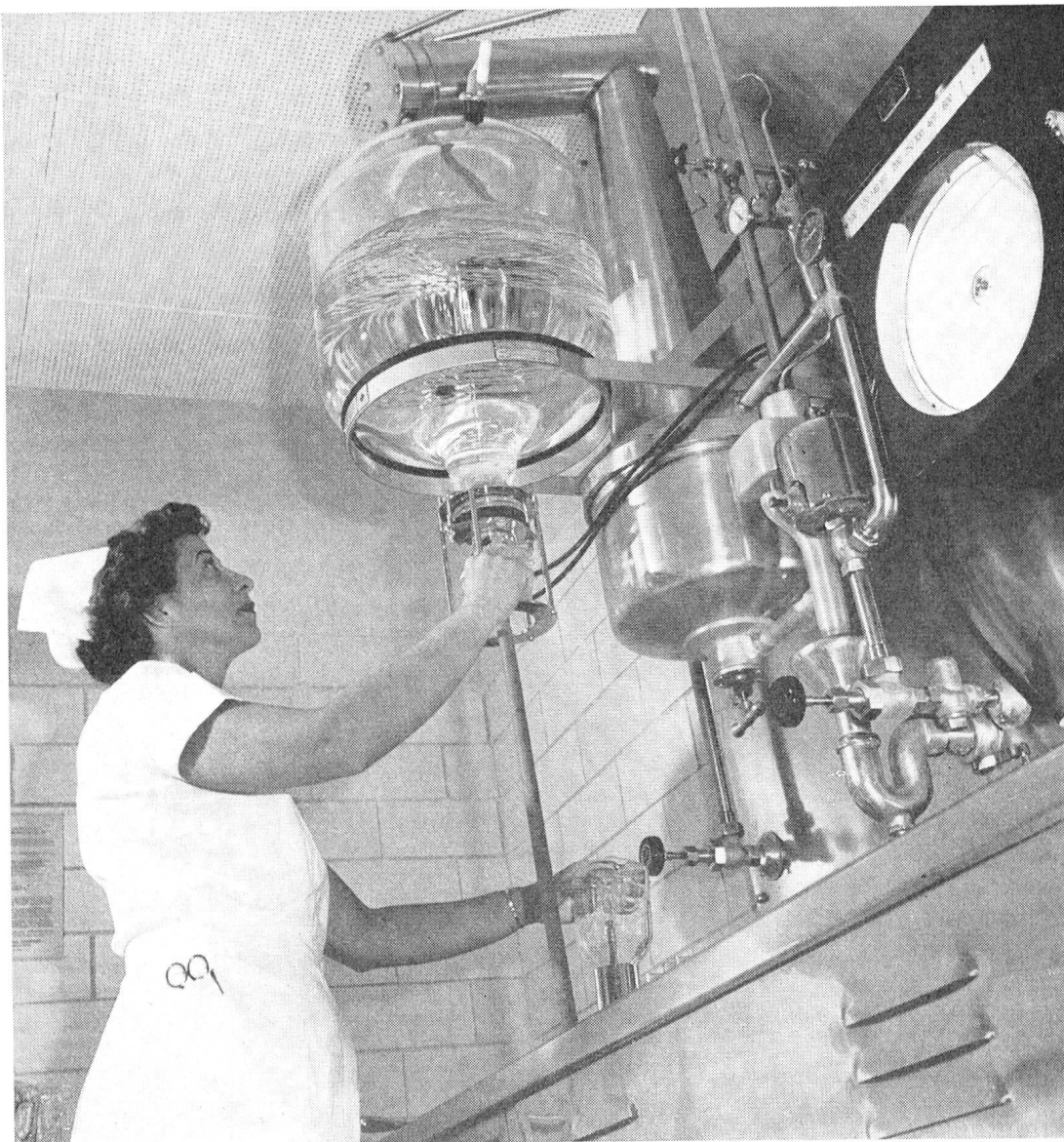
Mit dem Wasser aus dem Destillationsapparat werden Traubenzucker- und physiologische Lösungen im Spital selbst hergestellt.
