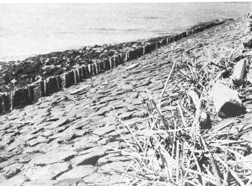
Das Bild links zeigt den Deichfussmantel aus Basaltsteinen im Bienenwabennmuster.
