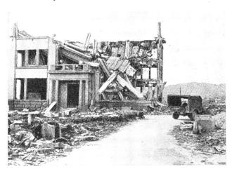
Abb. 3. Luftdruckwirkung; armierter Betonbau in rund 200 Metern Abstand vom Zentrum (Hiroshima). (Reprod. aus Report of the British Mission to Japan.)
