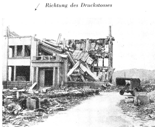
Abb. 3. Luftdruckwirkung; armerter Betonbau in rund 200 Metern Abstand vom Zentrum (Hiroshima). (Reprod. aus Report of the British Mission to Japan.)
