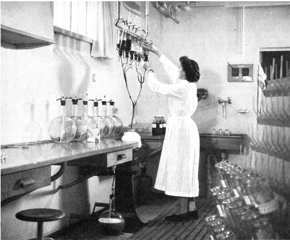
Das Blut wird Flasche nach Flasche durch eine kontinuierlich arbeitende Zentrifuge geschickt und das abgetrennte Plasma steril aufgefangen.
