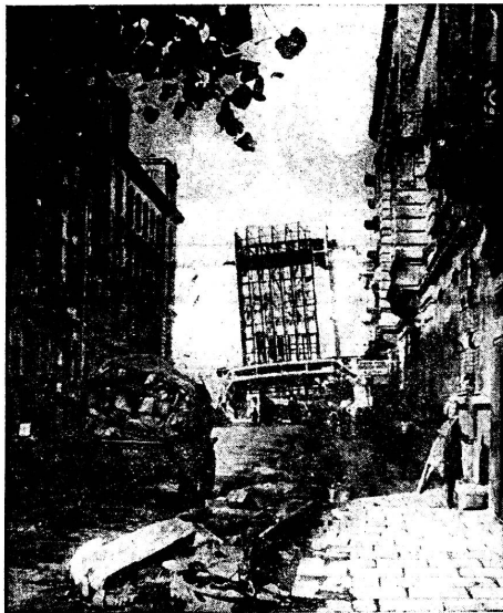
Das Gerippe des Hauptbahnhofs von Warschau La carcasse de la gare principale à Varsovie
